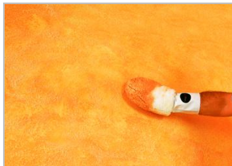
Fase 6 - Seconda mano, opzionale se si desidera 'invecchiare' il muro, ripassare dopo 15/30 minuti con il guanto inumidito di prodotto
